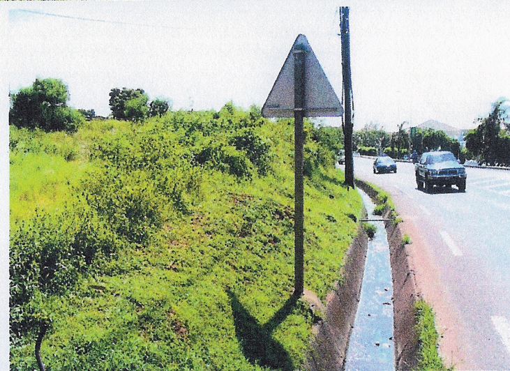
Photographie 3 : vue depuis l'angle N W, de la limite Nord, route de ceinture
